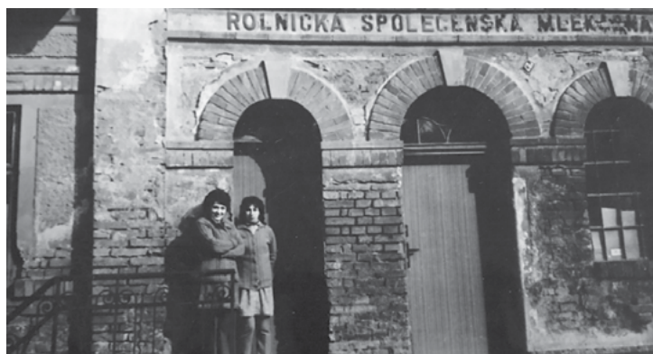
Bývalá mlékárna, v současnosti průmyslový areál. Fotka pořízena kolem r. 1975.
